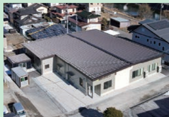
本社第二工場
